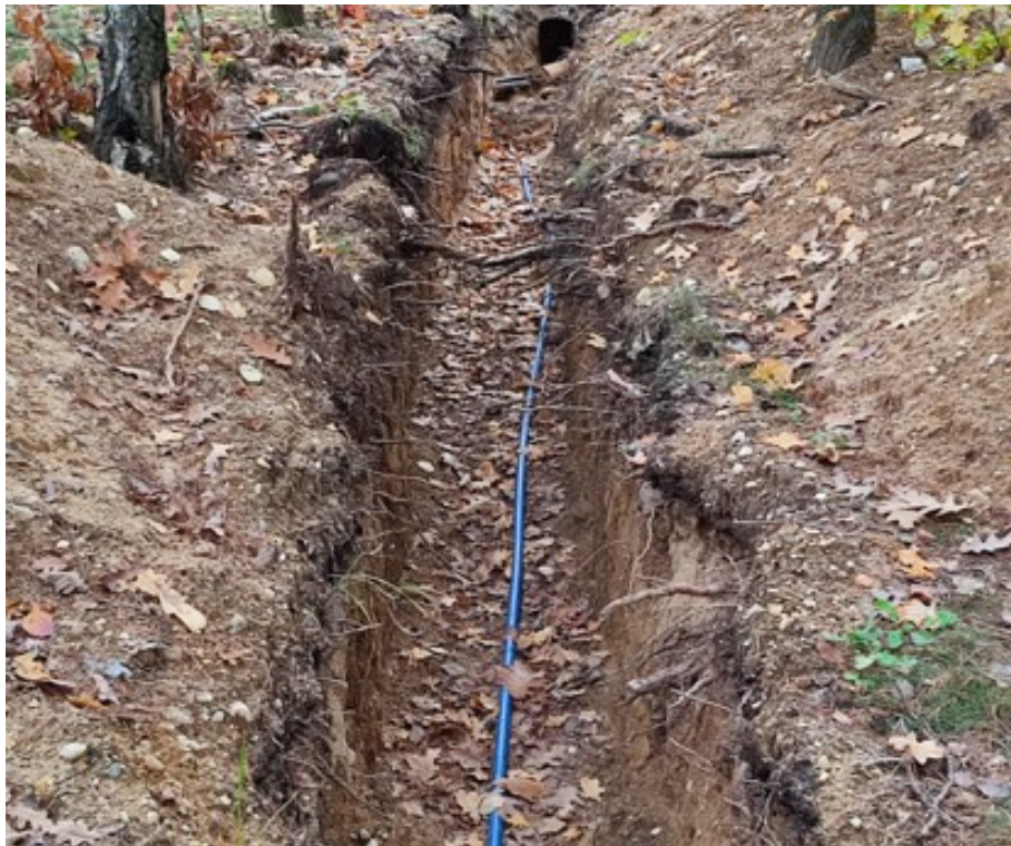
Verlegen der Trinkwasserleitung
